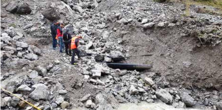
Freigelegte Druckrohrleitung und Kabel beim seitlichen Zubringer
