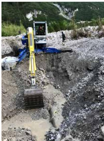
*Das in 2 m Tiefe verlegte Druckrohr wurde beim Hochwasserereignis Leck geschlagen.*
